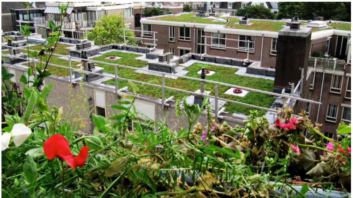
Afb. 3 Duurzaam vegetatiedak en gezamenlijk onderhoud door huurders (foto: Picasdre, Amsterdam)
