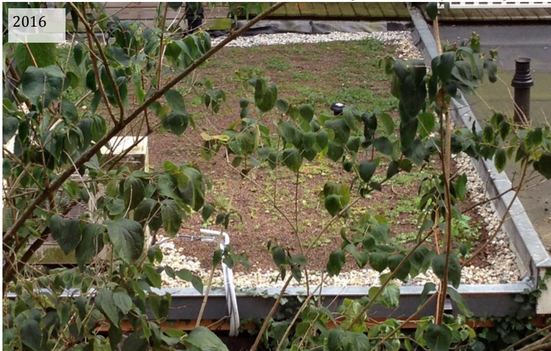
Afb. 17 Een (aanzet tot) groendak in binnenterrein #135 (achter de Kinkerstraat)
